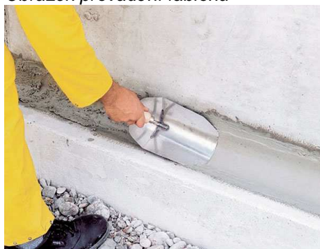
Obrázek provádění fabionu
